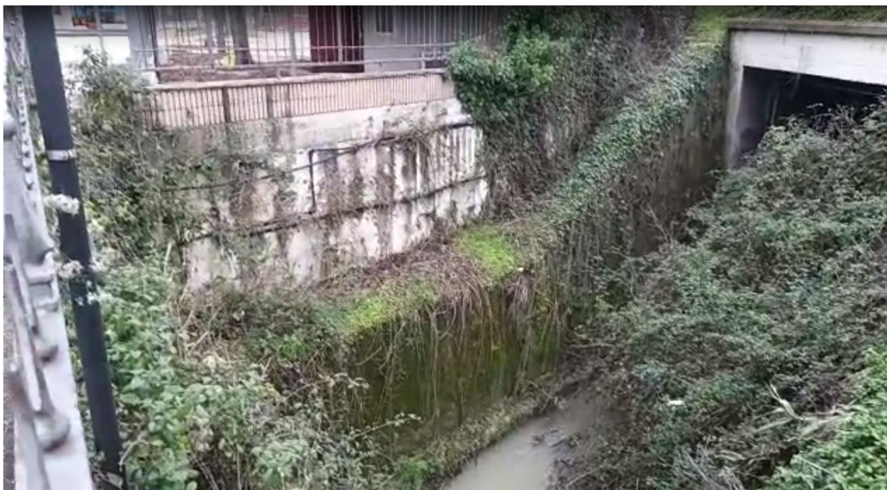
Foto n. 8 - Scorcio prospettico di valle dell'attraversamento fossato della S.R. 602, dove si evince la tipologia costruttiva, in c.a.
