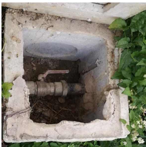
Foto n. 4 - Pozzetto adiacente esistente fossa imhoff
