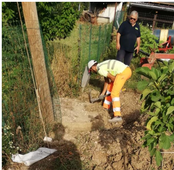
Foto n. 1 - Operazioni di pulizia della copertura esistente fossa imhoff
