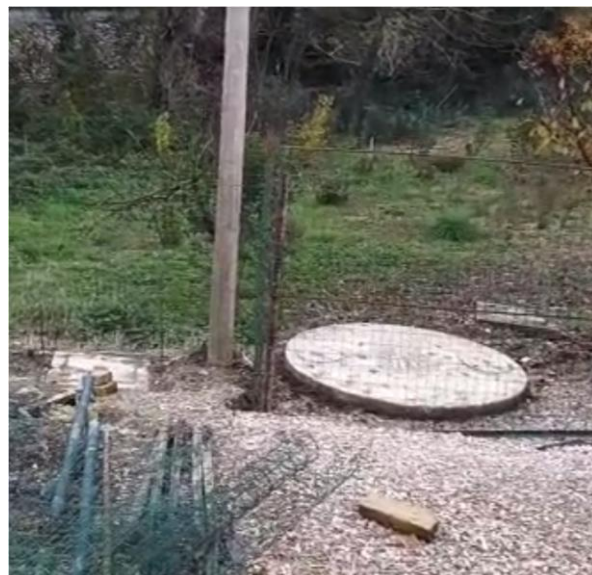
Foto n. 2 - Copertura esistente fossa imhoff
